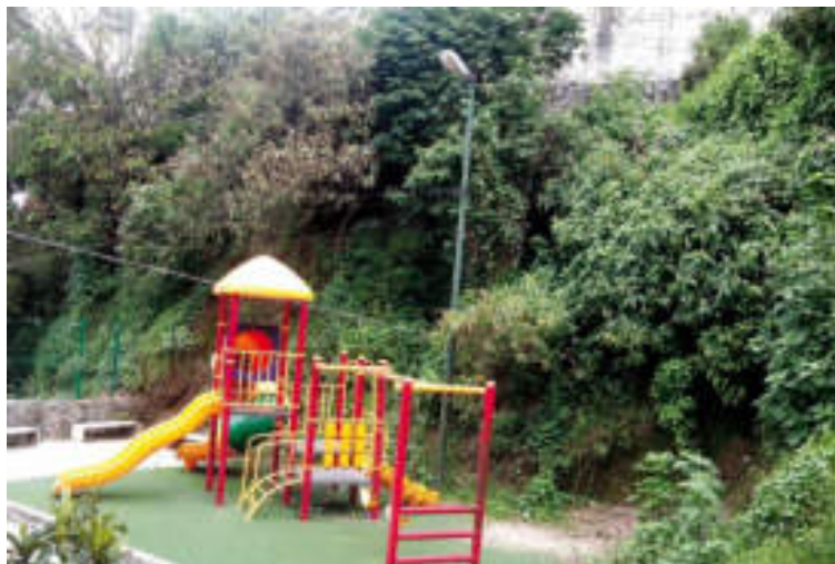
Figura 5.10. Fotografía A de la sección dos (1.2) del polígono de peligro Río San Borja. Zona de juegos infantiles a un costado de un talud compuesto por material no consolidado. A los costados de los juegos infantiles se observa la falta de vegetación a consecuencia de los derrumbes y deslizamientos en la zona (19.3745° N, 99.2180° W. Calle: 26).
