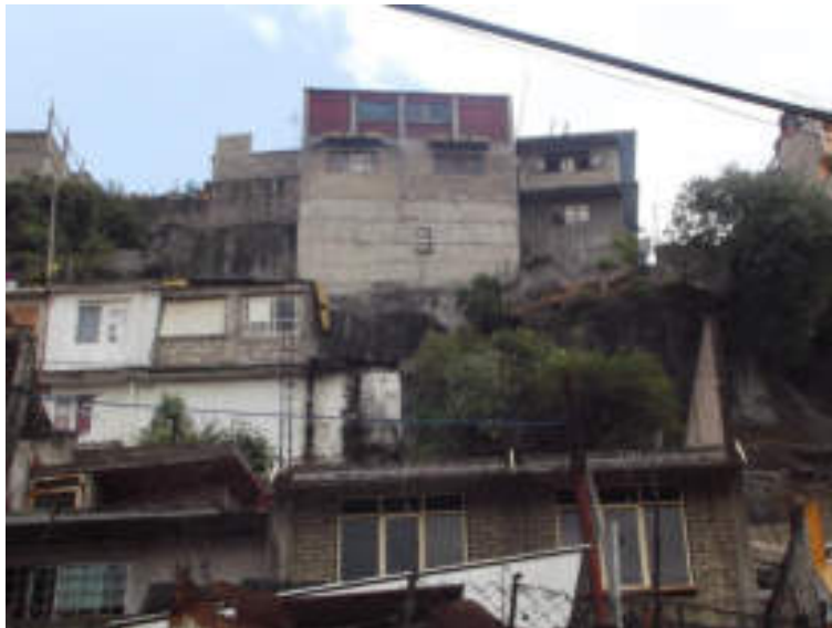
Figura 5.138. Fotografía B del polígono de peligro La Cañada. Viviendas desplantadas sobre un talud cubierto de concreto lanzado. El peso que estas construcciones ejercen en la ladera, además de la composición lítica del talud y la erosión a la que está expuesto, hacen que las viviendas estén en riesgo de derrumbarse (19.3810° N, 99.2256° W. Calle: El Risco).
