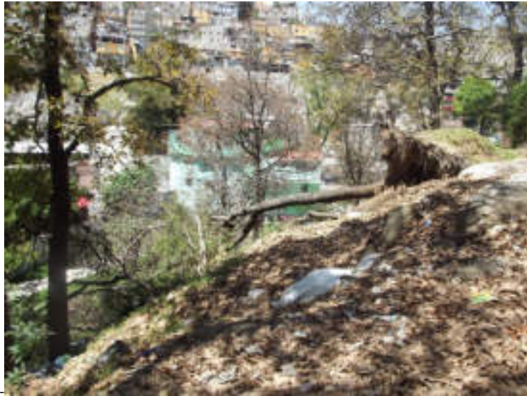
Figura 5.101. Fotografía B de la sección uno (11.1) del polígono de peligro Río Mixcoac. Al centro de la fotografía se observa un árbol que cayó a causa del reblandecimiento del material que lo sostenía ocurrido en época de lluvias. Al no estar consolidados, los materiales que componen el talud son propensos a los movimientos de remoción (19.3560° N, 99.2494° W. Calle: Acuilotitla).
