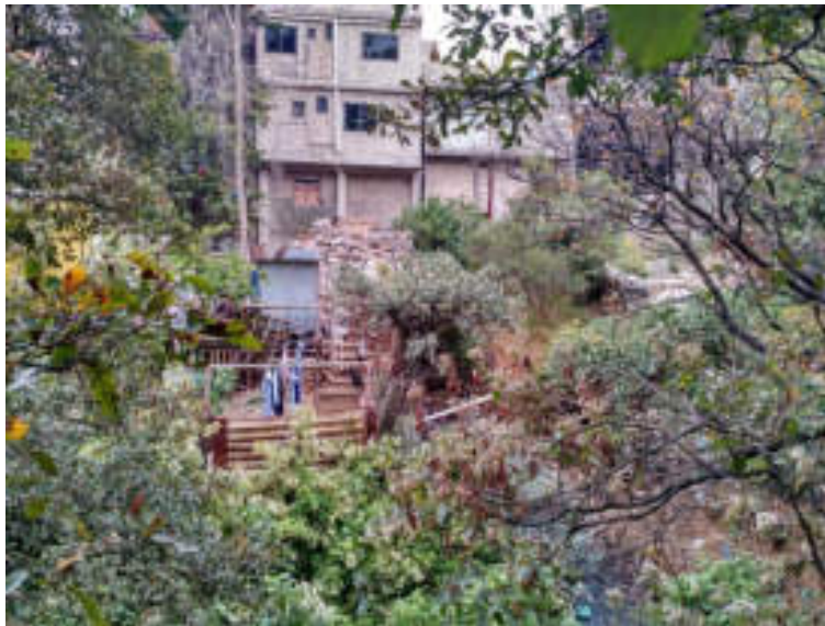
Figura 5.61. Fotografía A de la sección uno (6.1) del polígono de peligro Río Becerra. Se aprecia una vivienda construida en uno de los flancos de la barranca, la cual tiene una estructura débil y poco resistente a los fenómenos de remoción a los que está expuesta; obsérvese el uso de costales rellenos apilados al centro de la imagen como medida de contención (19.3664° N, 99.2454° W. Calle: Comalteco)
