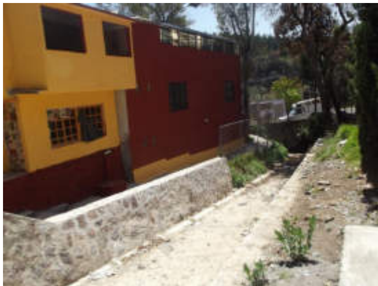
Figura 5.100. Fotografía A de la sección uno (11.1) del polígono de peligro Río Mixcoac. Se observa que un tramo de la barranca ha sido encauzado y entubado. También se distinguen muros de contención a los costados del cauce (19.3550° N, 99.2554° W. Calle: 1).
