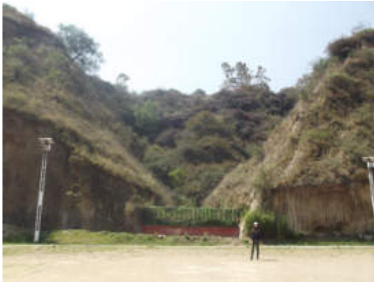
Figura 5.151. Fotografía C de la sección uno (18.1) del polígono de peligro Tlalpizahuaya. Zona de depósito en medio de dos taludes, donde hay presencia de flujos de lodo. Los flujos de lodo han sobrepasado el muro de contención que evitaba que los materiales invadieran las instalaciones deportivas (19.3773° N, 99.2370° W. Calle: sin nombre oficial).
