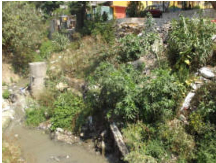
Figura 5.149. Fotografía A de la sección uno (18.1) del polígono de peligro Tlalpizahuaya. Fotografía que muestra un muro de contención aledaño al cauce de la barranca, el cual presenta colapsos a causa de la remoción del material no consolidado en uno de los flancos. En la parte superior de la imagen puede observarse costales apilados que presentan erosión y cuyo relleno queda expuesto a la intemperie (19.3780° N, 99.2379° W). Calle: Pueblo Nuevo).
