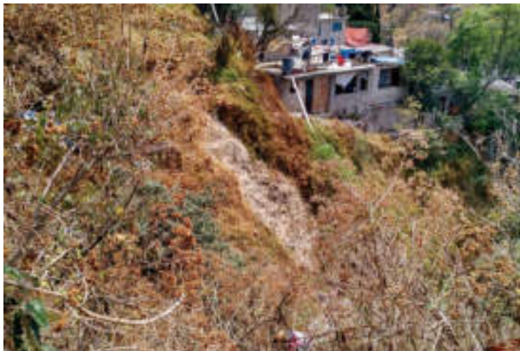
Figura 5.81. Fotografía C de la sección uno (8.1) del polígono de peligro Puerta Grande. Talud compuesto de depósitos volcánicos inestables cubierto parcialmente de vegetación. Las construcciones asentadas en este tipo de morfologías están en constante peligro por la remoción continua de los materiales deleznales, causada por la acción de los agentes erosivos (19.3521° N, 99.2405° W. Calle: sin nombre oficial).
