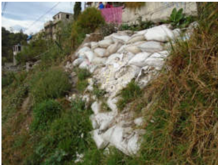
Figura 5.122. Fotografía B de la sección 13.3 del polígono de peligro Tacubaya. Costales rellenos de arena y cemento apilados en una porción de la ladera, los cuales están deteriorados a causa de la erosión e invasión de la vegetación; la vía de comunicación presenta un volado (19.3911° N, 99.2154° W. Calle: Polacos).
