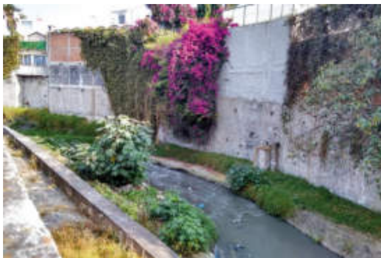
Figura 5.49. Fotografía C de la sección cuatro (4.4) del polígono de peligro Guadalupe. En la fotografía se observa la corriente del Río Guadalupe, la cual se encuentra encauzada; hacia el final del polígono de peligro, la pendiente de los flancos de la barranca disminuye drásticamente (19.3474° N, 99.2164° W. Calle: Colina).
