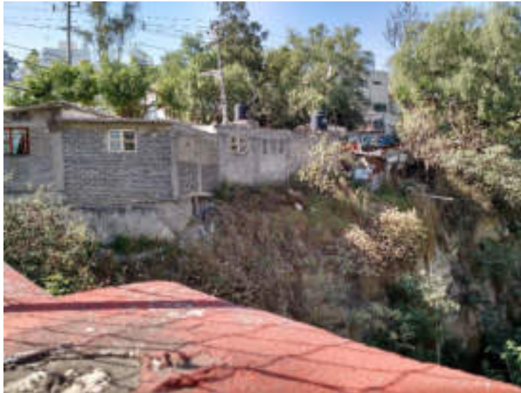
Figura 5.50. Fotografía D de la sección cuatro (4.4) del polígono de peligro Guadalupe. Construcción semiconfinada asentada a la orilla de uno de los flancos de la barranca. Se observa al centro que presenta un volado por la remoción del material, el cual es sostenido solamente por una columna de cemento endeble. A la derecha, se observa un muro hecho de materiales precarios, el cual presenta inclinación con dirección a la pendiente (19.3468° N, 99.2078° W. Calle: Flor de María).
