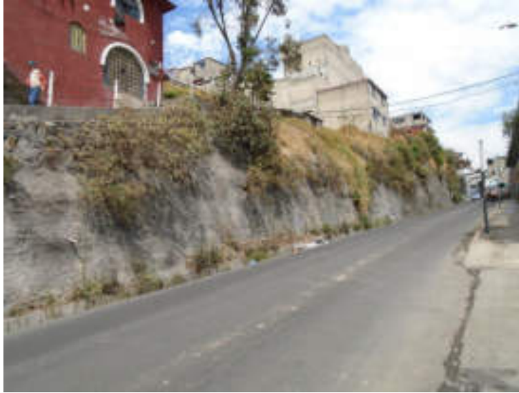
Figura 5.134. Fotografía A del polígono de vulnerabilidad Corpus Christy. En la fotografía se muestra un talud de aproximadamente 5 m de altura, el cual cuenta con un recubrimiento de concreto en su superficie. El concreto lanzado es un uso muy difundido en los lugares donde hay presencia de barrancas con el fin de evitar la remoción del material; sin embargo, la vegetación y la erosión los desgastan y deterioran (19.3611° N, 99.2465° W. Calle: San Isidro Alto Lerma).
