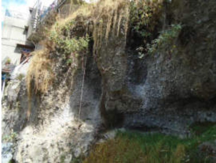
Figura 5.114. Fotografía B de la sección uno (13.1) del polígono de peligro Tacubaya. Fotografía que muestra la litología de la que está compuesta la barranca (depósitos volcánicos) y la erosión que presenta debido a la acción que ejercen la vegetación y el agua. En la parte superior izquierda, se puede observar una vivienda asentada sobre el talud que presenta un volado y que es vulnerable ante los derrumbes del material inestable (19.3819° N, 99.2458° W. Calle: Barranca Morena).
