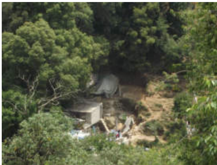
Figura 5.160. Fotografía A de la sección uno (19.1) del polígono de peligro Atzoyapan. Zona de depósito cubierta por una lona de plástico; por debajo, se observa una construcción precaria desplantada en un corte de la ladera (19.3209° N, 99.2867° W. Calle: Arroyo Huayatlaco).
