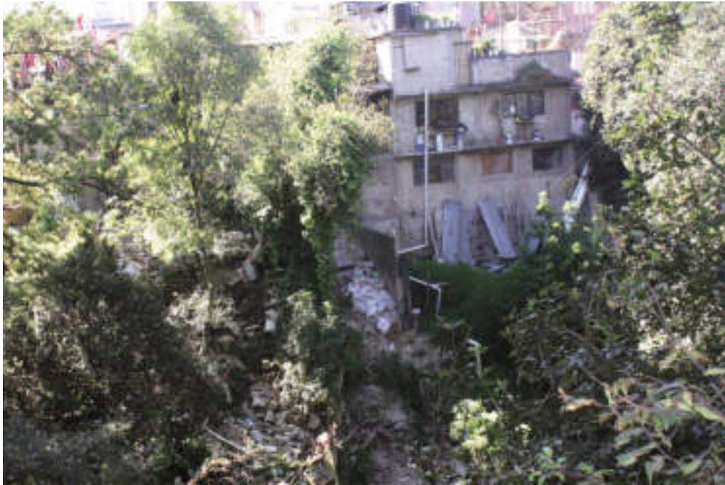
Figura 5.18. Fotografía A de la sección uno (2.1) del polígono de peligro Texcalatlaco, la cual muestra una vivienda establecida en la pared de la barranca; a la izquierda se observa el derrumbe de un muro de contención hecho con costales (19.3137° N, 99.2650° W. Calle: 1.º Cerrada de La Paz).
