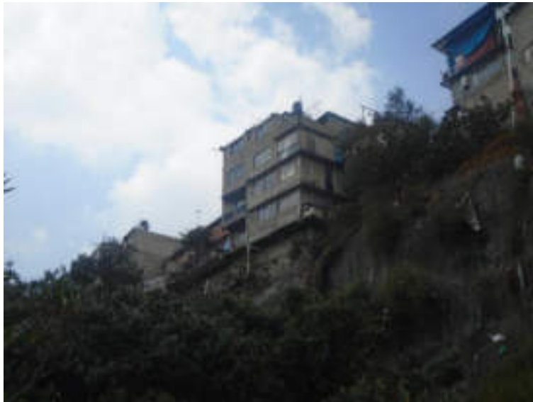
Figura 5.65. Fotografía B de la sección dos (6.2) del polígono de peligro Río Becerra. Se observa una vivienda de varios niveles desplantada sobre un talud cubierto de concreto lanzado. Se puede apreciar que la construcción presenta un volado sin ningún tipo de soporte (19.3742° N, 99.2275° W. Calle: sin nombre oficial).
