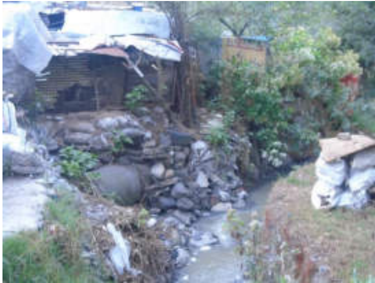
Figura 5.66. Fotografía C de la sección dos (6.2) del polígono de peligro Río Becerra. Construcción precaria desplantada a un costado del cauce del río. Se puede observar al centro de la fotografía que es sostenida por costales apilados deteriorados. Por la precariedad de los materiales y su cercanía al río, esta vivienda está en alto riesgo ante los fenómenos de remoción en masa (19.3758° N, 99.2277° W. Calle: Balmaceda).
