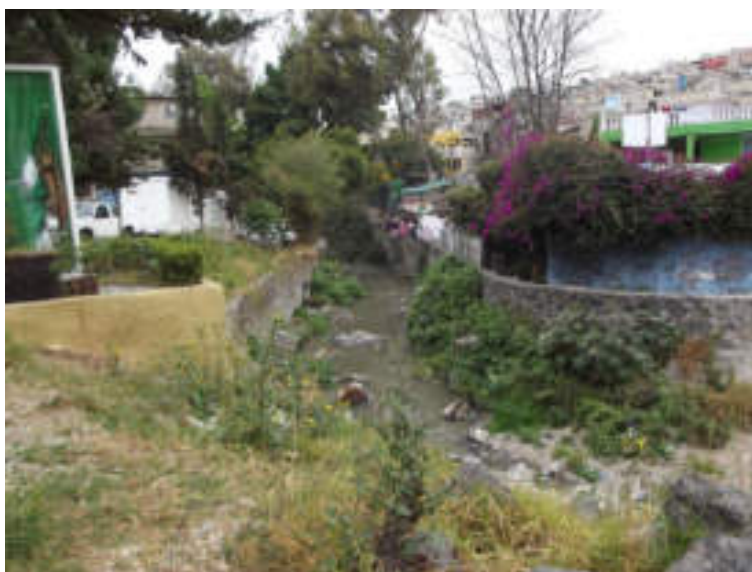
Figura 5.157. Fotografía B de la sección tres (18.3) del polígono de peligro Tlalpizahuaya. Fotografía que muestra que la corriente del río Tlalpizahuaya se encuentra encauzada; se puede observar una barda perimetral que bordea al cauce (19.3812° N, 99.2264° W. Calle: Cañada del Río Pinto).
