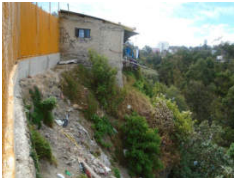
Figura 5.113. Fotografía A de la sección uno (13.1) del polígono de peligro Tacubaya. Vista hacia la barranca, donde se aprecia que la pendiente de la ladera es casi vertical; la vivienda que se observa al centro de la fotografía está desplantada en la orilla de la ladera sobre materiales sin consolidar y presenta una ligera inclinación hacia la pendiente ( 19.3814^{\circ} N, 99.2463^{\circ} W. Calle: Barranca Morena).
