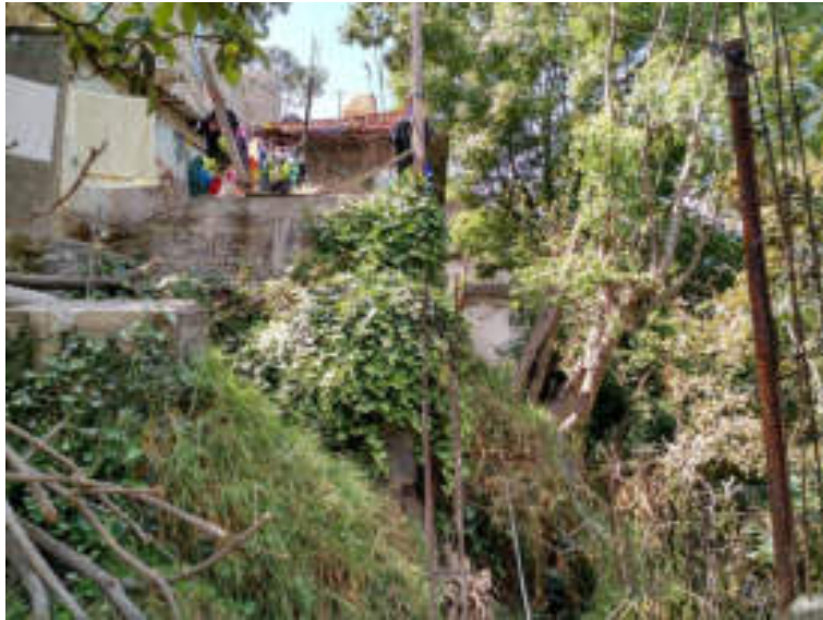
Figura 5.62. Fotografía B de la sección uno (6.1) del polígono de peligro Río Becerra. En esta fotografía es posible observar una vivienda desplantada sobre un talud inestable; esto se denota en la inclinación de los árboles ubicados a un costado de la construcción. Se aprecia también la ruptura del muro perimetral de la vivienda (19.3686° N, 99.2361° W. Calle: Roble).
