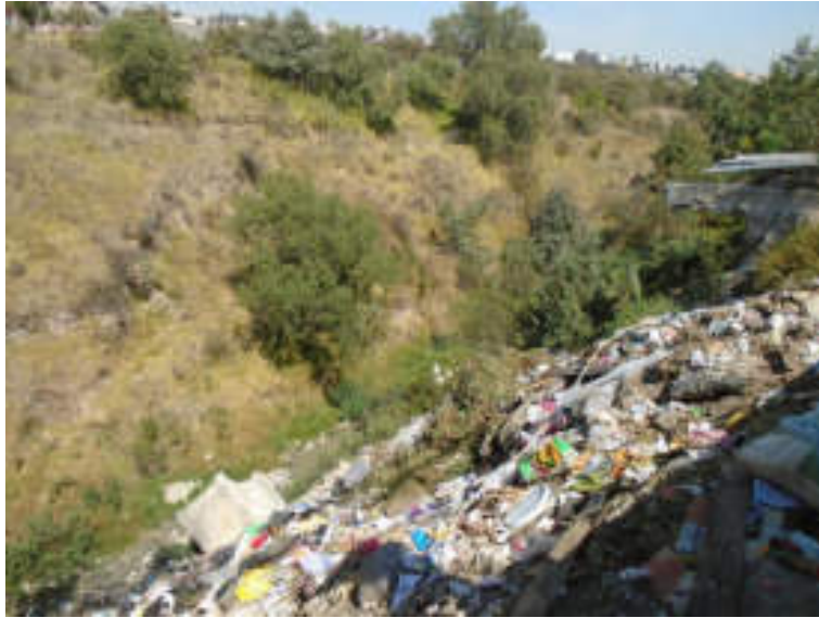
Figura 5.75. Fotografía A de la sección dos (7.2) del polígono de peligro Tarango. En esta fotografía se aprecia una construcción que cayó por la ladera debido a un derrumbe; lo único que aún se sostiene es una trabe que se distingue a la derecha de la fotografía (19.3569° N, 99.2163° W. Calle: Tarango).
