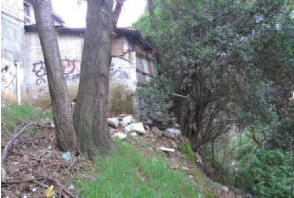
Figura 5.20. Fotografía C de la sección uno (2.1) del polígono de peligro Texcalatlaco. Vivienda en orilla de la parte alta del flanco de la barranca montada sobre costales apilados; a la derecha se observa un árbol inclinado por la inestabilidad del terreno (19.3234° N, 99.2570° W. Calle: Fresnos).
