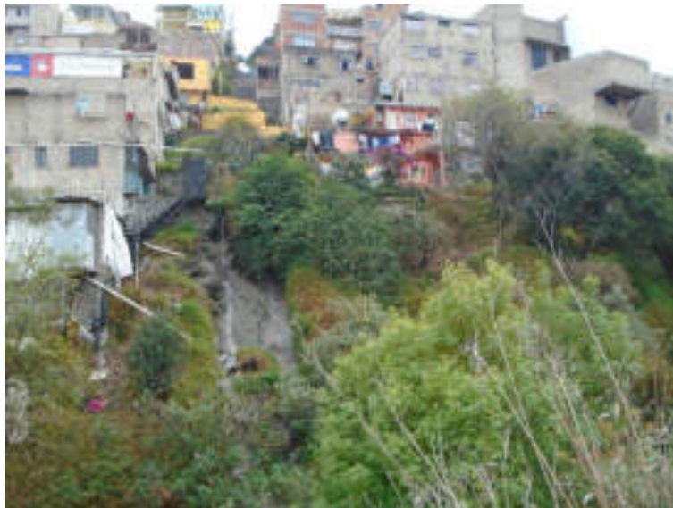
Figura 5.154. Fotografía B de la sección dos (18.2) del polígono de peligro Tlalpizahuaya. En la fotografía se distinguen algunas construcciones desplantadas en uno de los flancos de la barranca. Se observa que la descarga del drenaje de algunas viviendas es directamente sobre la ladera, lo cual contribuye a que los materiales pierdan cohesión y su posterior caída (19.3786° N, 99.2335° W. Calle: Andador 1).
