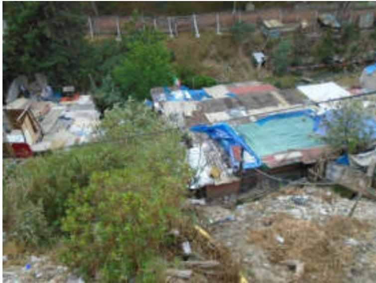
Figura 5.121. Fotografía A de la sección 13.3 del polígono de peligro Tacubaya. En la fotografía se aprecian algunas viviendas construidas con materiales precarios como láminas, lonas y madera, las cuales están asentadas en uno de los flancos de la barranca Tacubaya. En la parte superior de la fotografía, se distingue un muro de contención sostenido por columnas, las cuales se encuentran deterioradas por el movimiento del talud (19.3912° N, 99.2154° W. Calle: Polacos).
