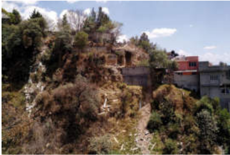
Figura 5.84. Fotografía B de la sección dos (8.2) del polígono de peligro Puerta Grande. En ella se observan varias construcciones asentadas sobre una ladera compuesta de depósitos inestables. Al centro de la fotografía es posible distinguir un derrumbe inmediato al muro de una vivienda (19.3522° N, 99.2371° W. Calle: sin nombre oficial).
