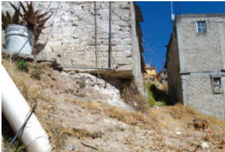
Figura 5.129. Fotografía B del polígono de vulnerabilidad Santa Lucía. En la fotografía se aprecian algunas viviendas que están construidas sobre un talud inestable. Debido a la remoción de los materiales, la vivienda de la izquierda presenta un volado en su estructura (19.3571° N, 99.2519° W. Calle: 2.º San Isidro Alto Lerma).
