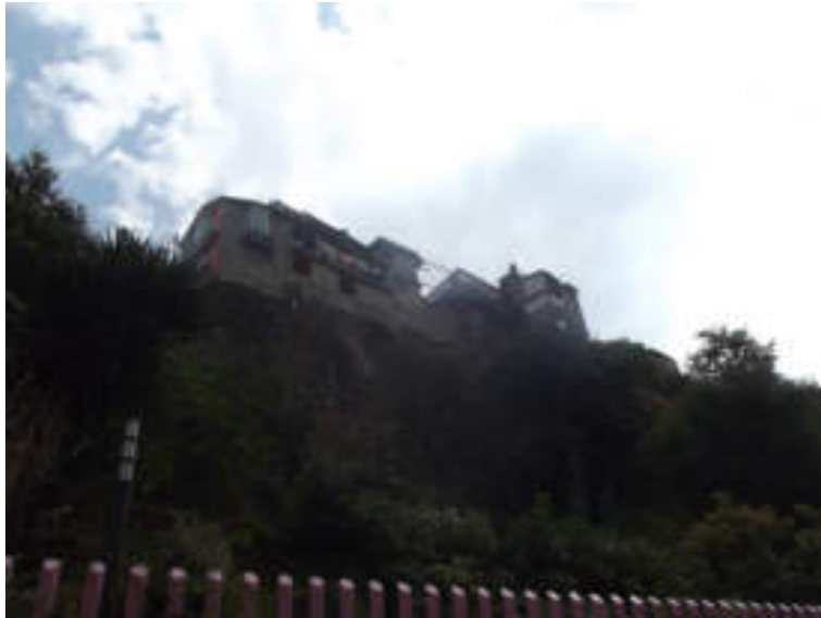
Figura 5.139. Fotografía C del polígono de peligro La Cañada. Vivienda desplantada a orillas de un talud inestable. La vivienda presenta un volado y cimientos expuestos, lo que la hace vulnerable al no tener soporte (19.3828° N, 99.2233° W. Calle: Pedro Moreno).
