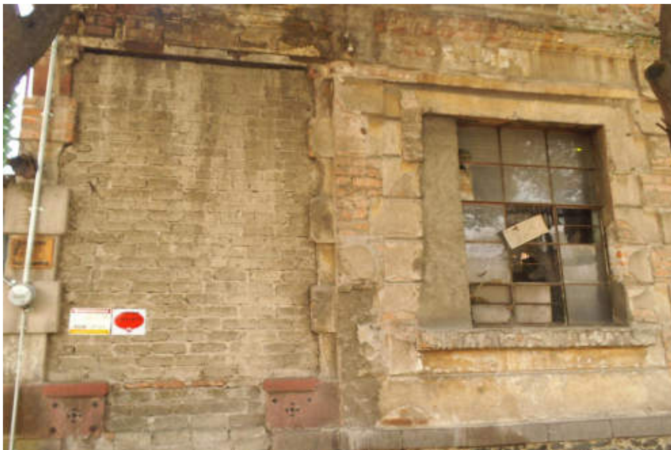
Figura 5.261. Fotografía A (Imagen 44), donde se observa una vivienda construida con diversos materiales y deterioro de los mismos (19.4715º N, 99.1867º W. Calle: Gacetilla).
