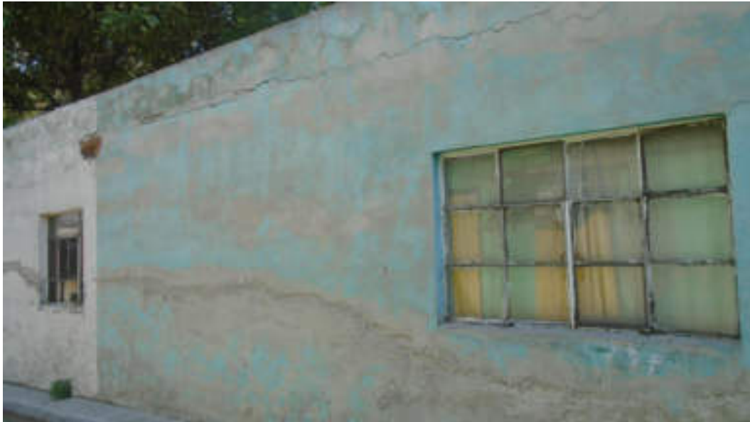
Figura 5.181. Fotografía H (Imagen 28), que muestra la fachada de una vivienda afectada por una fractura horizontal en la parte inferior y otra en la parte superior de la misma (19.4901° N, 99.1548° W. Calle: De la Morena).
