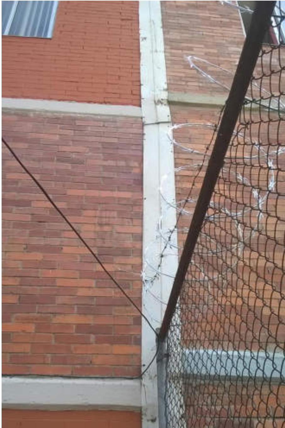
Figura 5. 21. Fotografía B (Imagen X), se observa un desplazamiento vertical de uno de los edificios con respecto al otro, esto es visible entre colindancias entre ellos (19.5057º N, 99.1861º W. Calle: 5 Norte (Deportivo Reynosa)).
