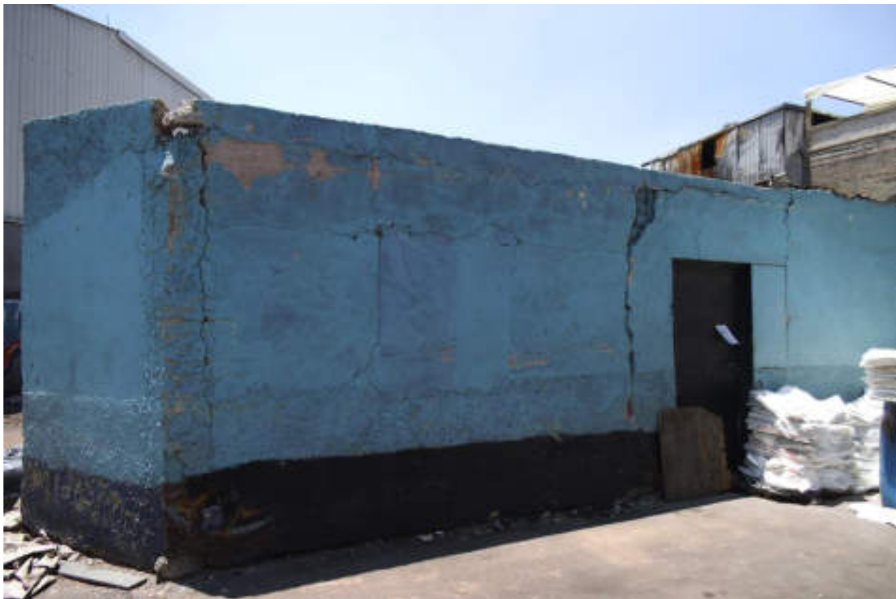
Figura 5.179. Fotografía F (Imagen 28a), observa una construcción que presenta una alta densidad de fracturas en toda su superficie, el lado izquierdo presenta una separación con respecto al resto del inmueble (19.4888° N; 99.1655° W. Calle: Maíz).
