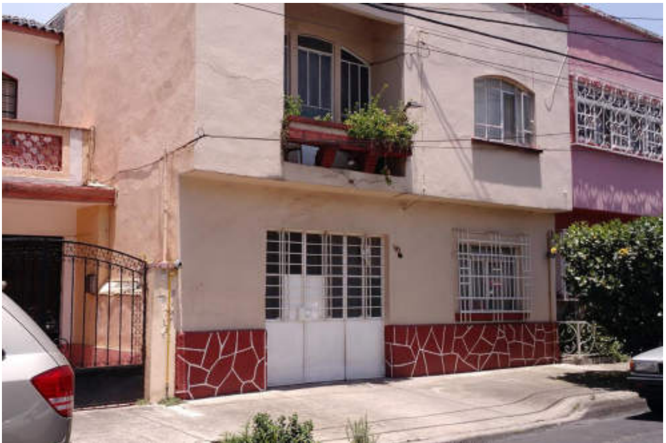
Figura 5.355. Fotografía A (Imagen 62), en ella se muestra una edificación de mampostería confinada, que presenta fracturas horizontales en la trabe que provoca la separación del elemento estructural, el muro izquierdo del nivel superior también presenta fracturamiento (19.4651º N, 99.1707º W. Calle: Piñón).
