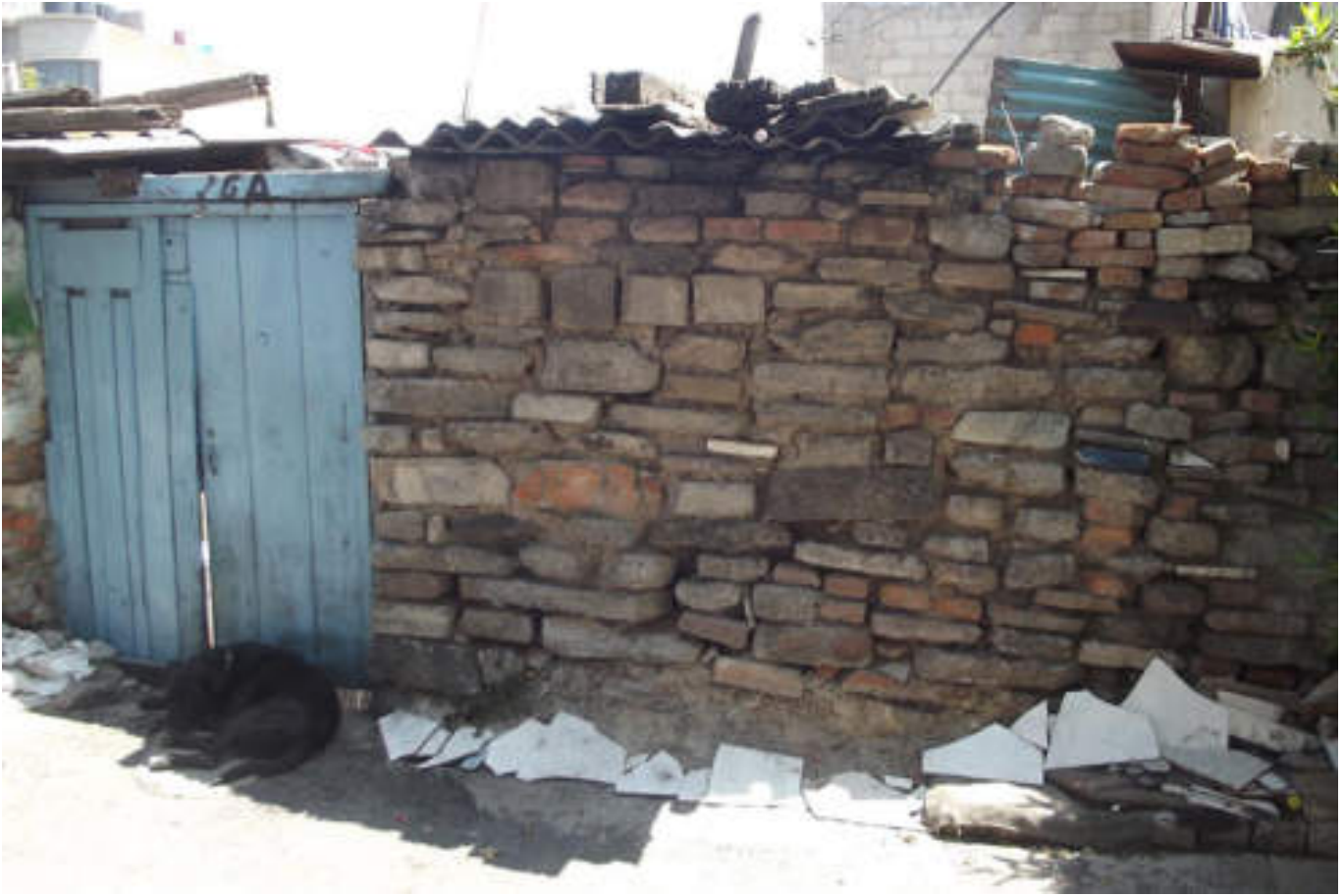
Figura 5.245. Fotografía C (Imagen 40), inmueble precario no confinado, de materiales constructivos mixtos, el techado se observa con lamina y polines de madera sobre ella (19.4724° N, 99.1461° W. Calle: 30).
