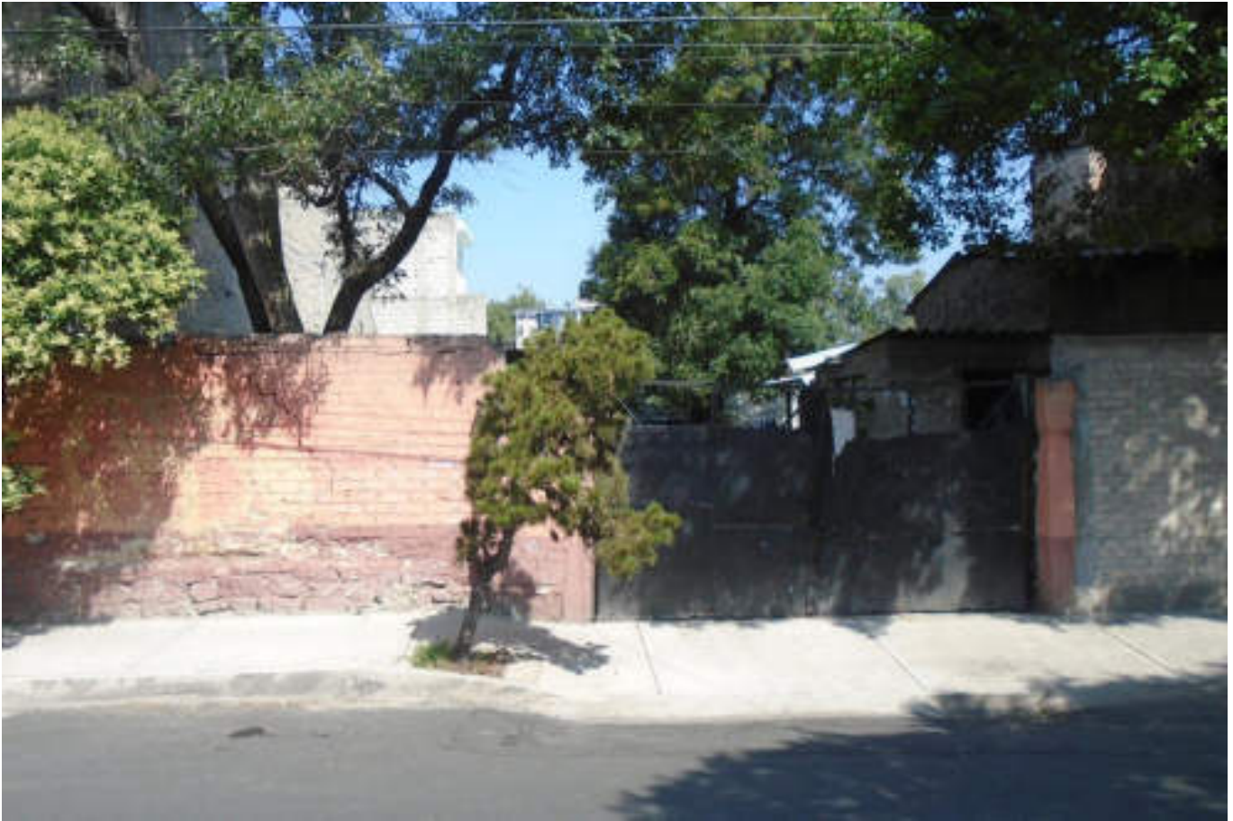
Figura 5.327. Fotografía B (Imagen 57), en la que podemos observar una vivienda de mampostería con diferentes procedimientos constructivos, muros de ladrillo unidos con mortero y piedra colocada unida con mortero la cual provoca que éste no trabaje como un mismo elemento y presente fracturas. La fractura puede apreciarse del lado izquierdo de la fotografía, ésta tiene forma diagonal escalonada debido a la mala calidad del material y la falta de refuerzos verticales y horizontales (19.4729° N, 99.1965° W. Calle: Gasoducto).
