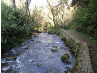
Contención del río hecho a base de piedra brasa.
