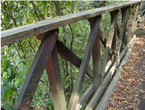
Puente construido con madera localizado entre el segundo y primer dinamo.
