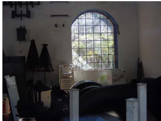
Imagen del interior del segundo dinamo, el cuál es utilizado como bodega por los comerciantes
