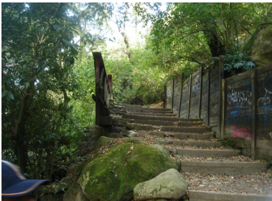
Construcción de escalinatas para facilitar el ascenso o descenso en el sitio. Se observa en la foto la construcción de muros en madera que seguramente es para la retención de deslaves en época de lluvia.
