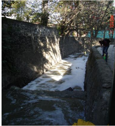
ZU4. Camino Santa Teresa y Av. México
